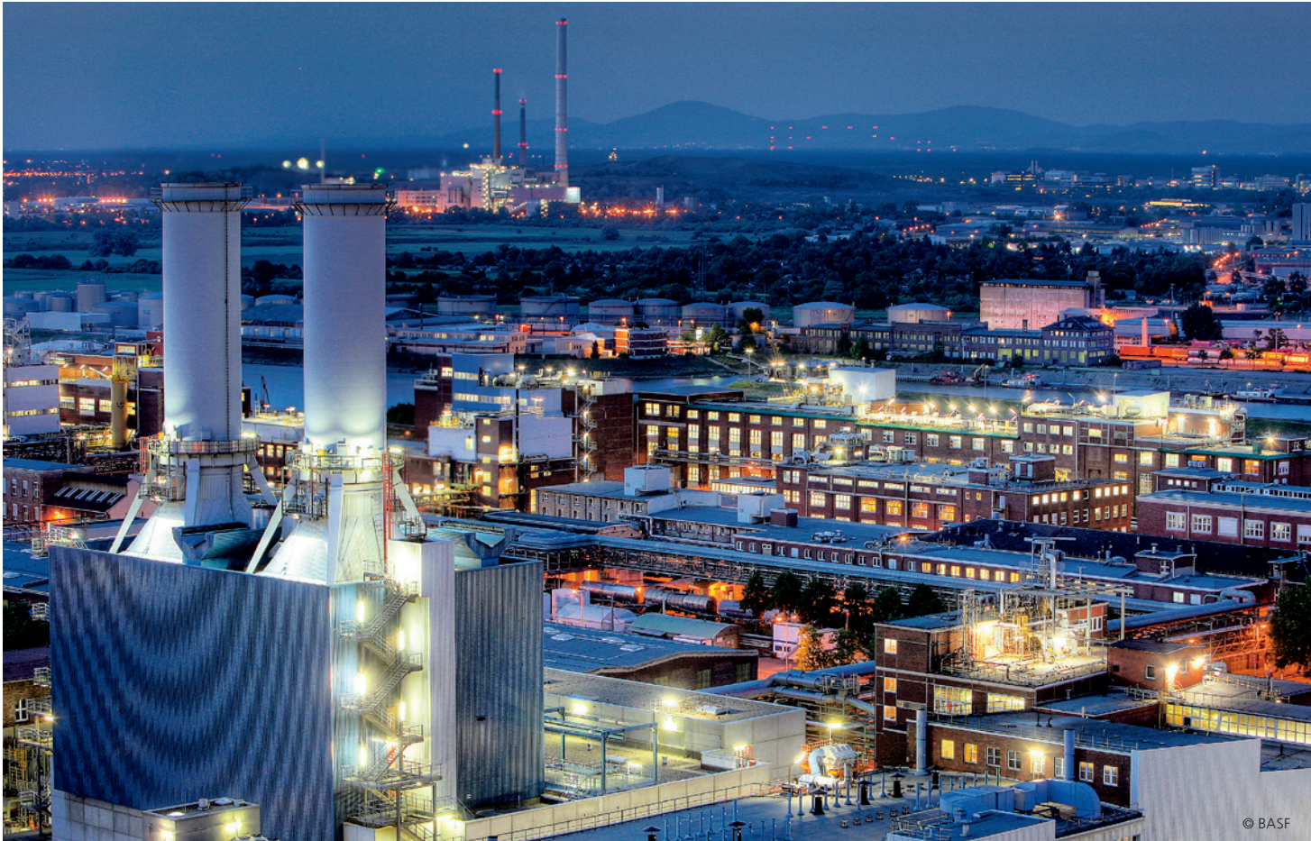
Das Stammwerk der BASF SE in Ludwigshafen ist der größte zusammenhängende Industriekomplex Europas. Das Fraunhofer ITWM arbeitet aktuell mit der BASF SE in einem gemeinsamen Projekt zur Realisierung virtueller »What-If-Szenarien« mithilfe von KI.
